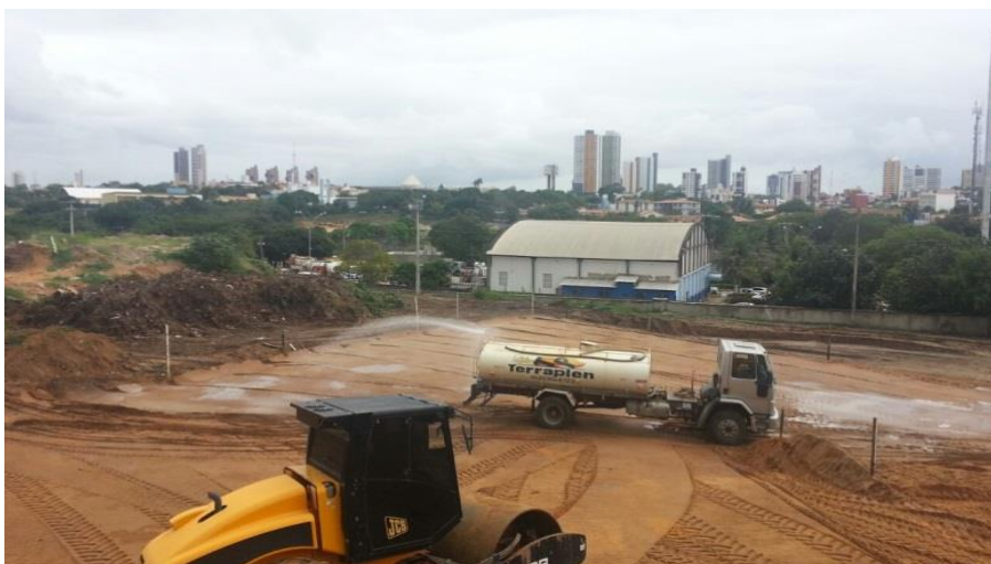
Figura 2 - Vista da execução da terraplanagem do Instituto do Cérebro - ICE/UFRN
