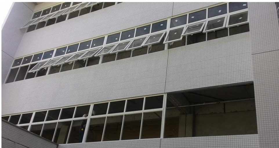
Figura 12 - Instalação de esquadrias
