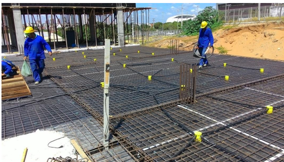
Figura 8 - Armação posicionada esperando concretagem
