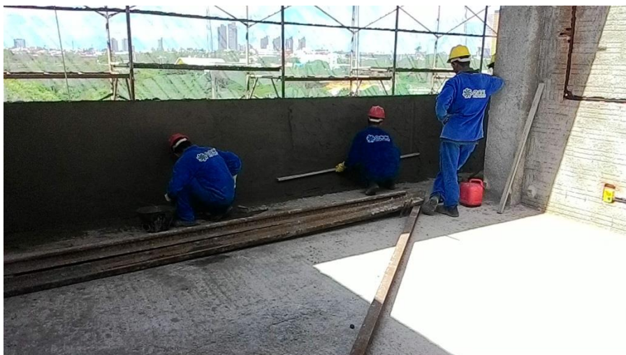
Figura 14 - Prumagem do reboco
