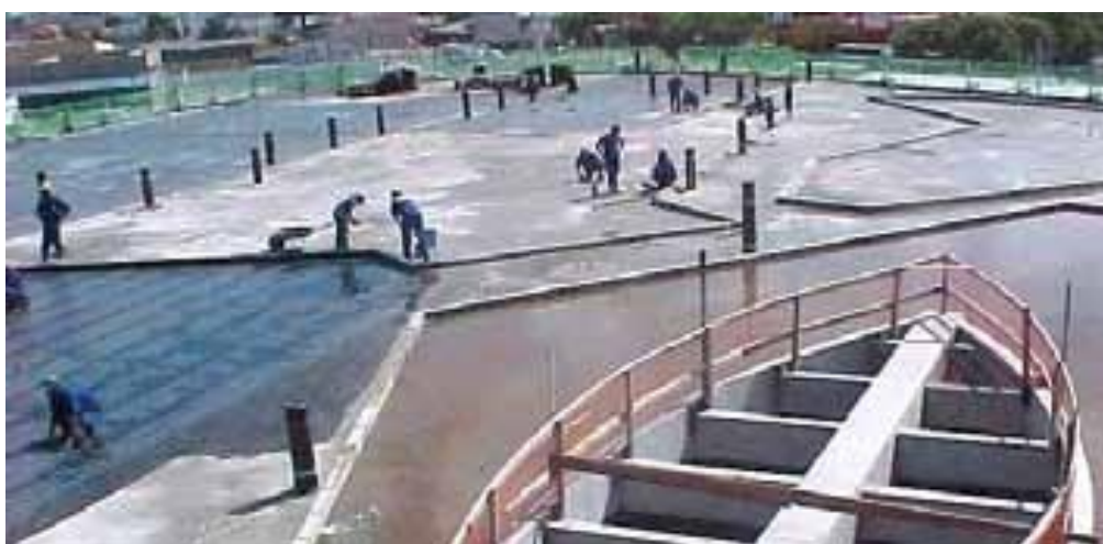
Figura 15 - Cobertura de edifício. Impermeabilização da laje para instalação de espelhos d'água e jardins
