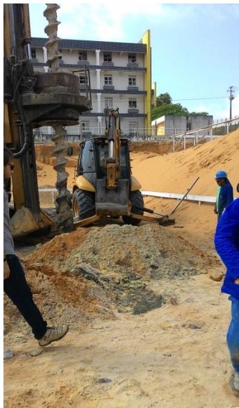
Figura 7 - Perfuração de solo para a execução de uma estaca de fundação
