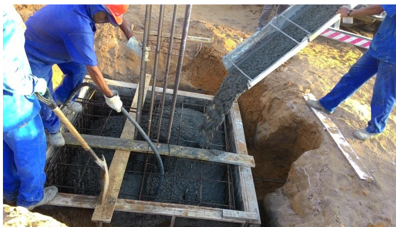
Figura 9 - Concretagem de um bloco de coroamento
