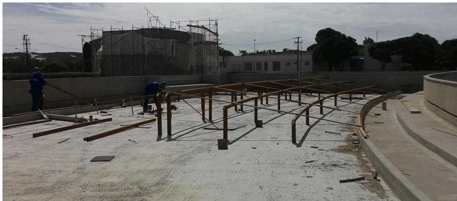
Figura 13 - Detalhe da cobertura de uma construção
